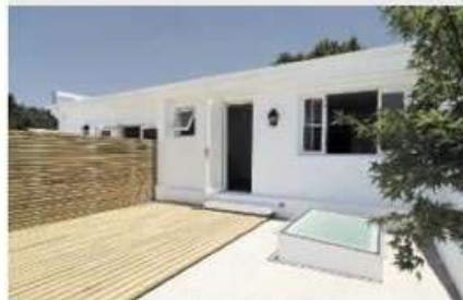
Para ahorrar energía, se abrieron lucarnas e instalaron paneles solares.
